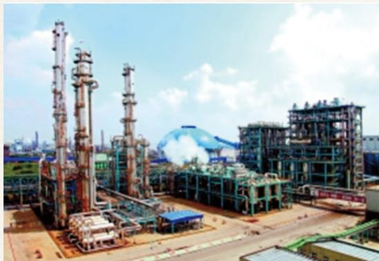
南化公司的9万吨/年煤制氢装置采用世界先进水煤浆气化工艺技术和高效环保处理系统，带动了老装置节能减排。图为装置区远景。(朱华南摄)
